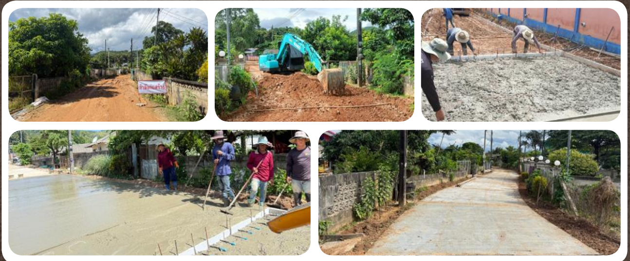
โครงการก่อสร้างรางระบายน้ำ ค.ส.ล. รูปตัวยู พร้อมฝารางระบายน้ำ ถนนเทศบาลซอย 56/4 หมู่ที่ 8 ตำบลแม่เมาะ
