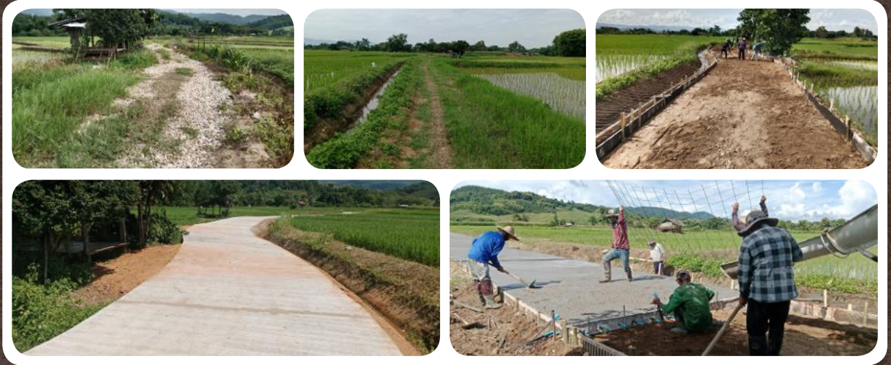
โครงการก่อสร้างถนนคอนกรีตเสริมเหล็ก ถนนเทศบาลซอย 44/2 (ฟาร์มไก่) หมู่ที่ 4 ตำบลแม่เมาะ
