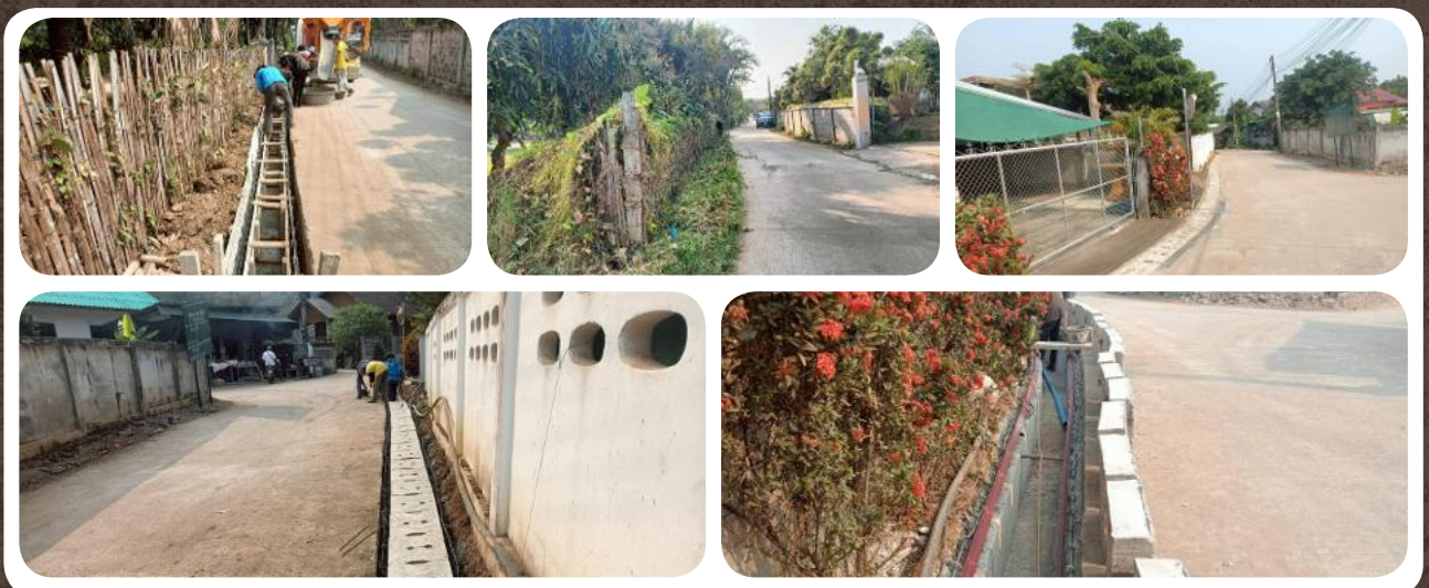
โครงการก่อสร้างรางระบายน้ำ ค.ส.ล. รูปตัวยู พร้อมฝารางระบายน้ำ ถนนเทศบาลซอย 56/4 หมู่ที่ 8 ตำบลแม่เมาะ
